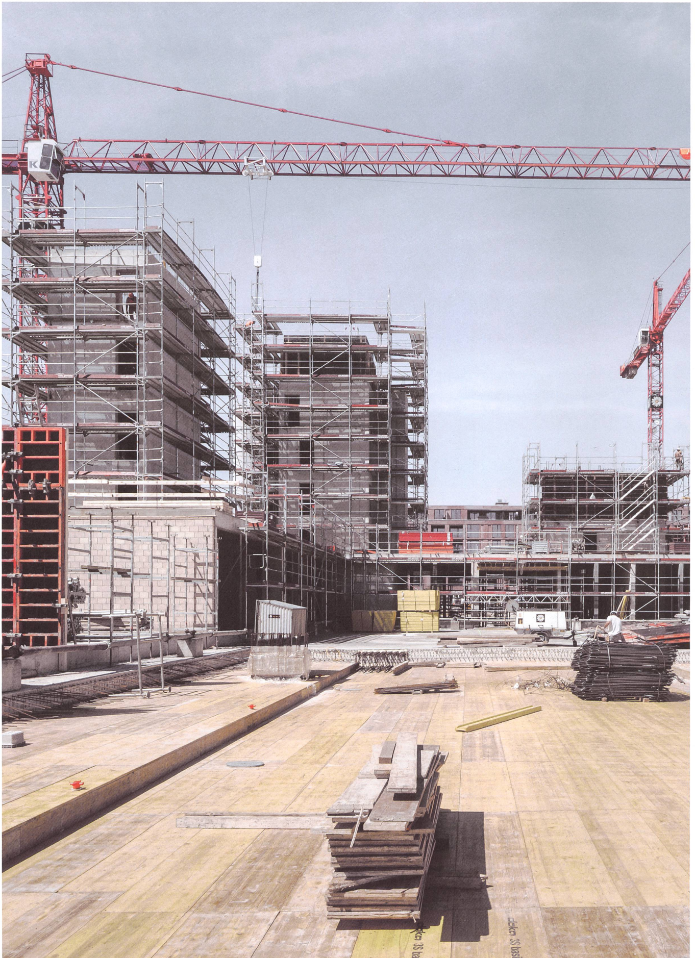
Vorfabrizierter Wohnungsbau: Nach dem Betonieren des Erdgeschosses und der Treppenhäuser dauerte die Montage der Holzbauelemente pro Etappe nur rund einen Monat.
