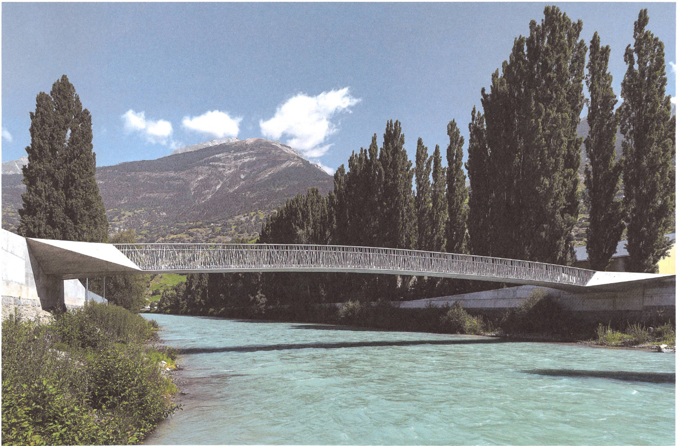
Vispa-Brücke bei Visp: Die Brücke als geschwungene Linie in einer von Geraden dominierten künstlichen Flusslandschaft. Foto: Thomas Jantscher
