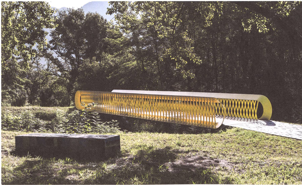
Hand in Hand haben Ingenieur und Architekt Form und Konstruktion der Brücke von Lumino entworfen. Foto: Filippo Broggin
