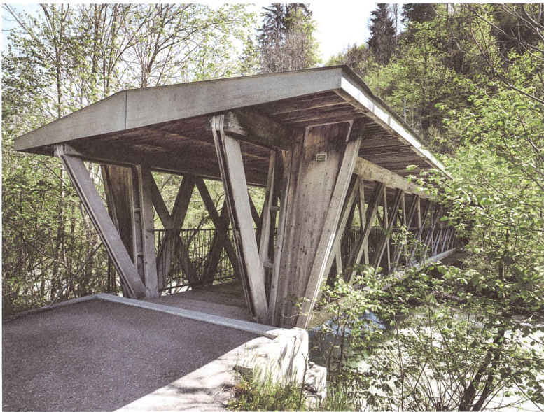
Das Dach schützt das Brücklein bei Garstatt und gibt ihm ein starkes Zeichen. Fotos: Caspar Martig
