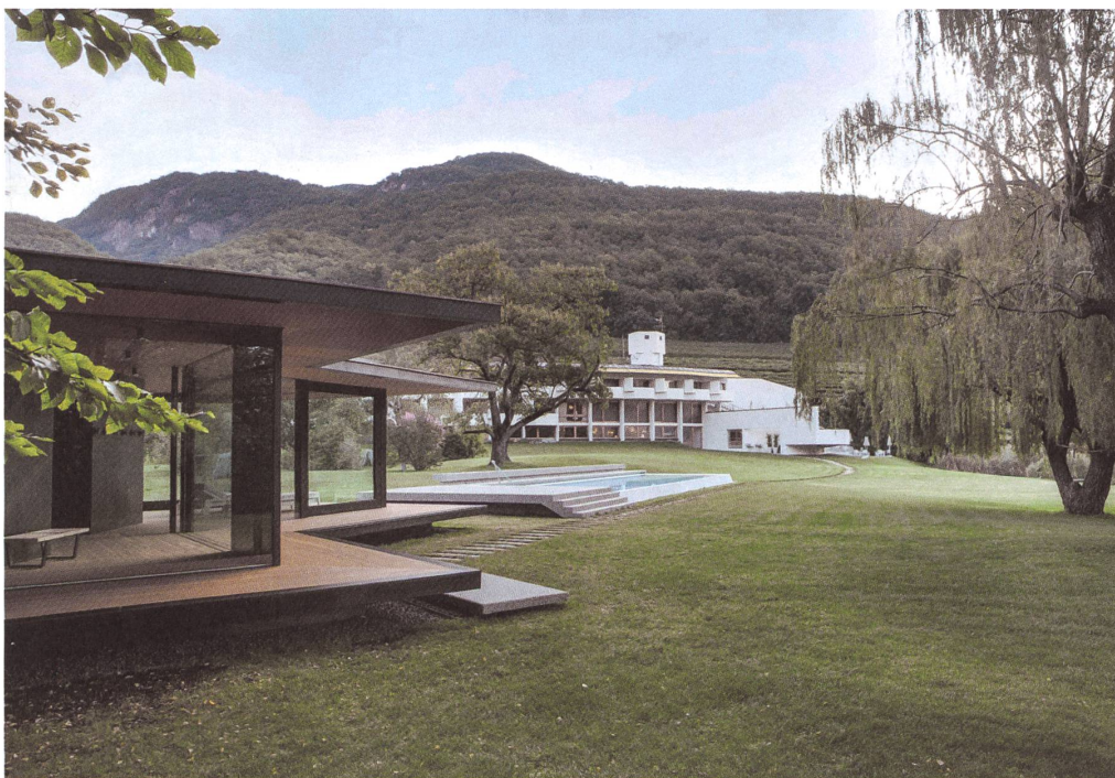
Hinten das bekannte Seehotel Ambach aus den 1970er-Jahren, vorn der luxuriöse Spa-Pavillon von Walter Angonese.
