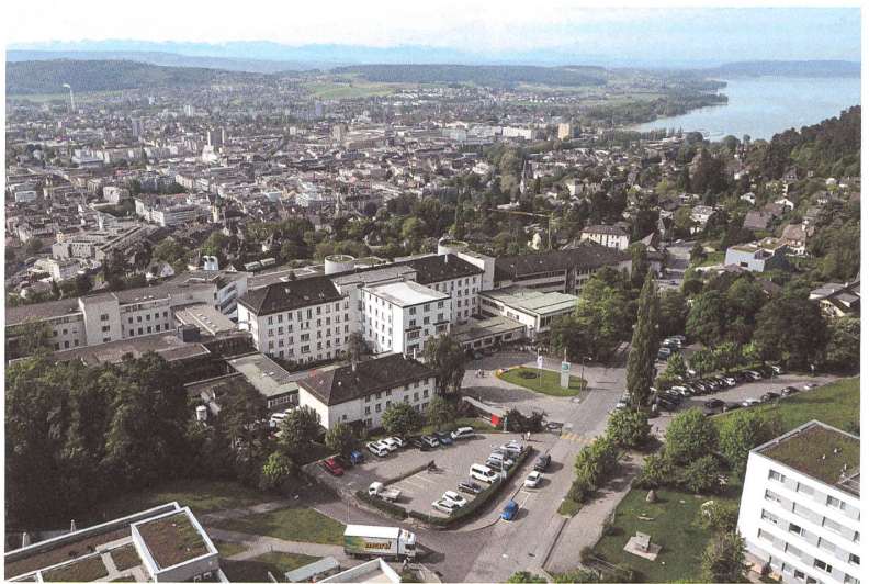
1 Inzwischen hat die Stadt den Standort eingeholt: Das Spital liegt am Rand eines Wohnquartiers. Foto: Archiv Spitalzentrum Biel
