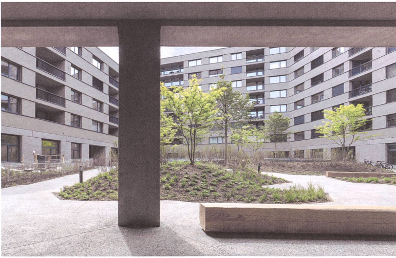
Bäleo Erlenmatt: Unter dem geneigten Hof liegt ein Einkaufszentrum.
