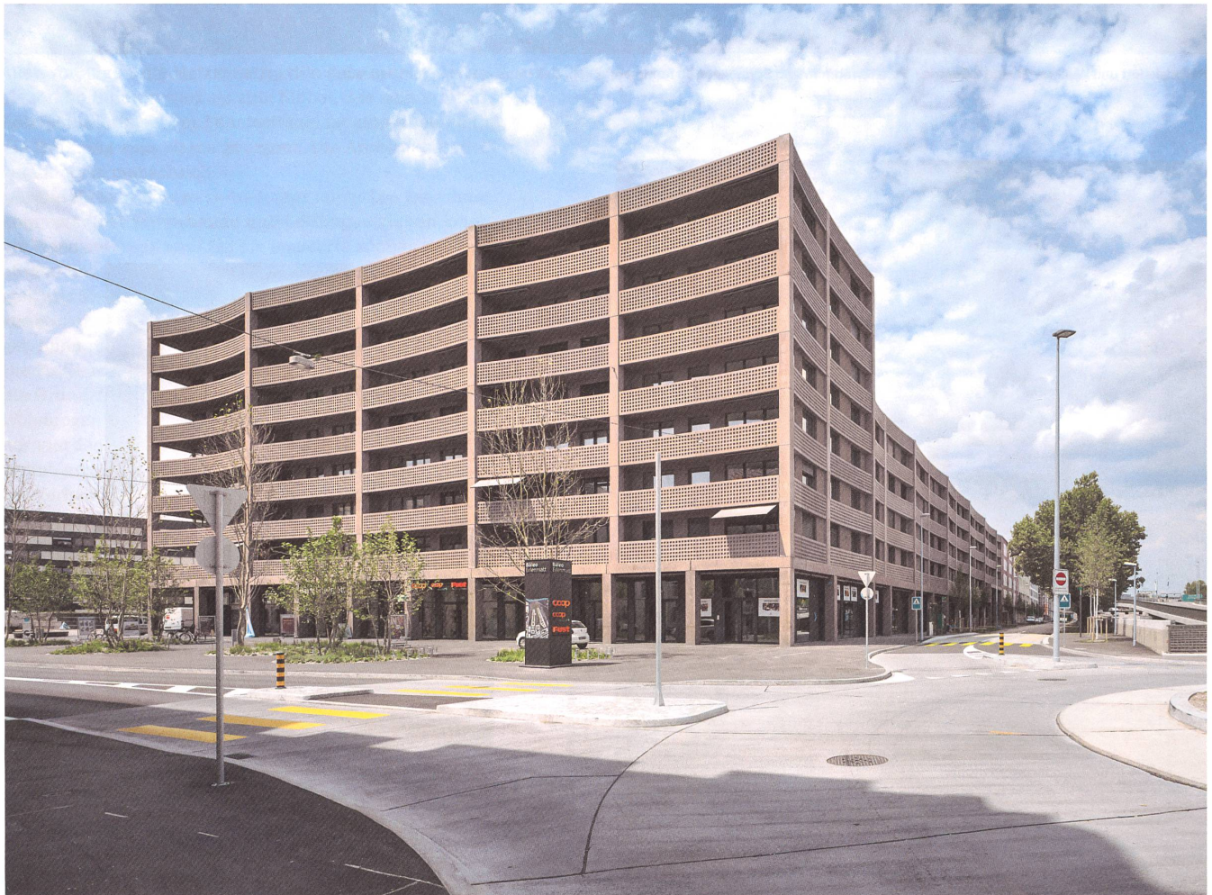
Wucht, geboren aus dem Ort: rechts die Autobahn, links die Überbauung «Erlentor», mit der die Erschliessung des Erlenmatt-Areals in Basel begann.
