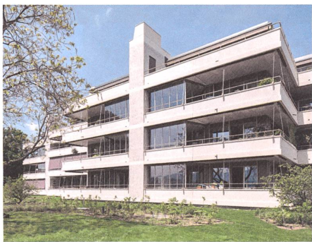
Neubau am einstigen Sitz der «Zürichsee-Zeitung» in Stäfa: Kamintürme prägen die markante Silhouette zum See.
