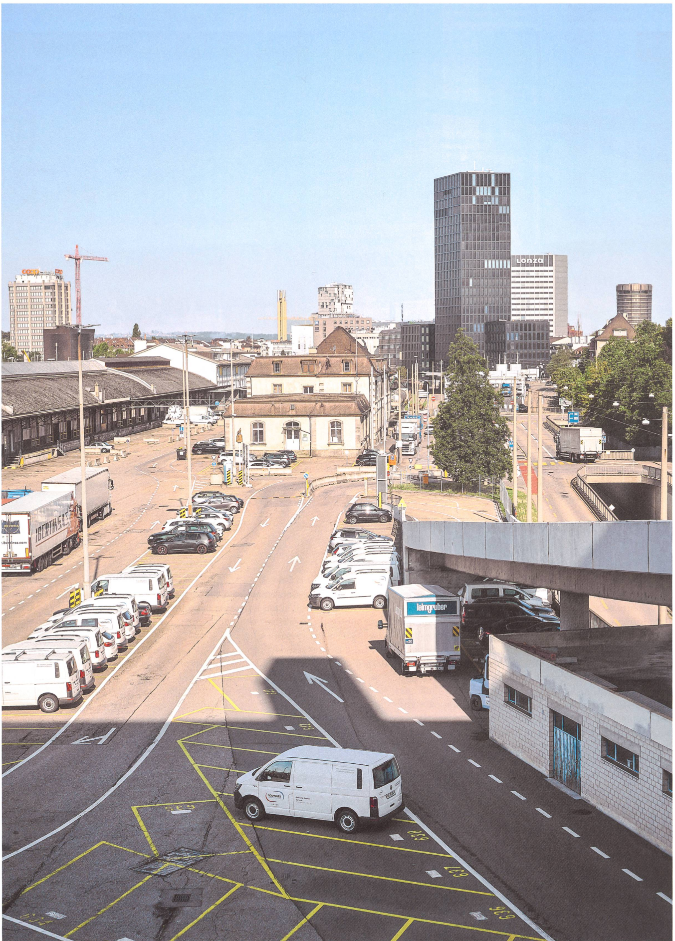
Heute von Logistik und Infrastruktur geprägt soll der Güterbahnhof Wolf sich in wenigen Jahren in ein lebendiges Stadtquartier verwandeln.
