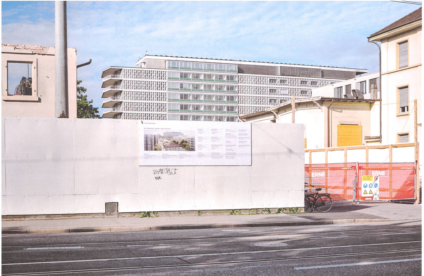
Recycling statt Abriss: Das Felix-Platter-Spital wird für Wohnungen und Gemeinschaftsräume umgenutzt, davor entstehen Genossenschaftsneubauten.
