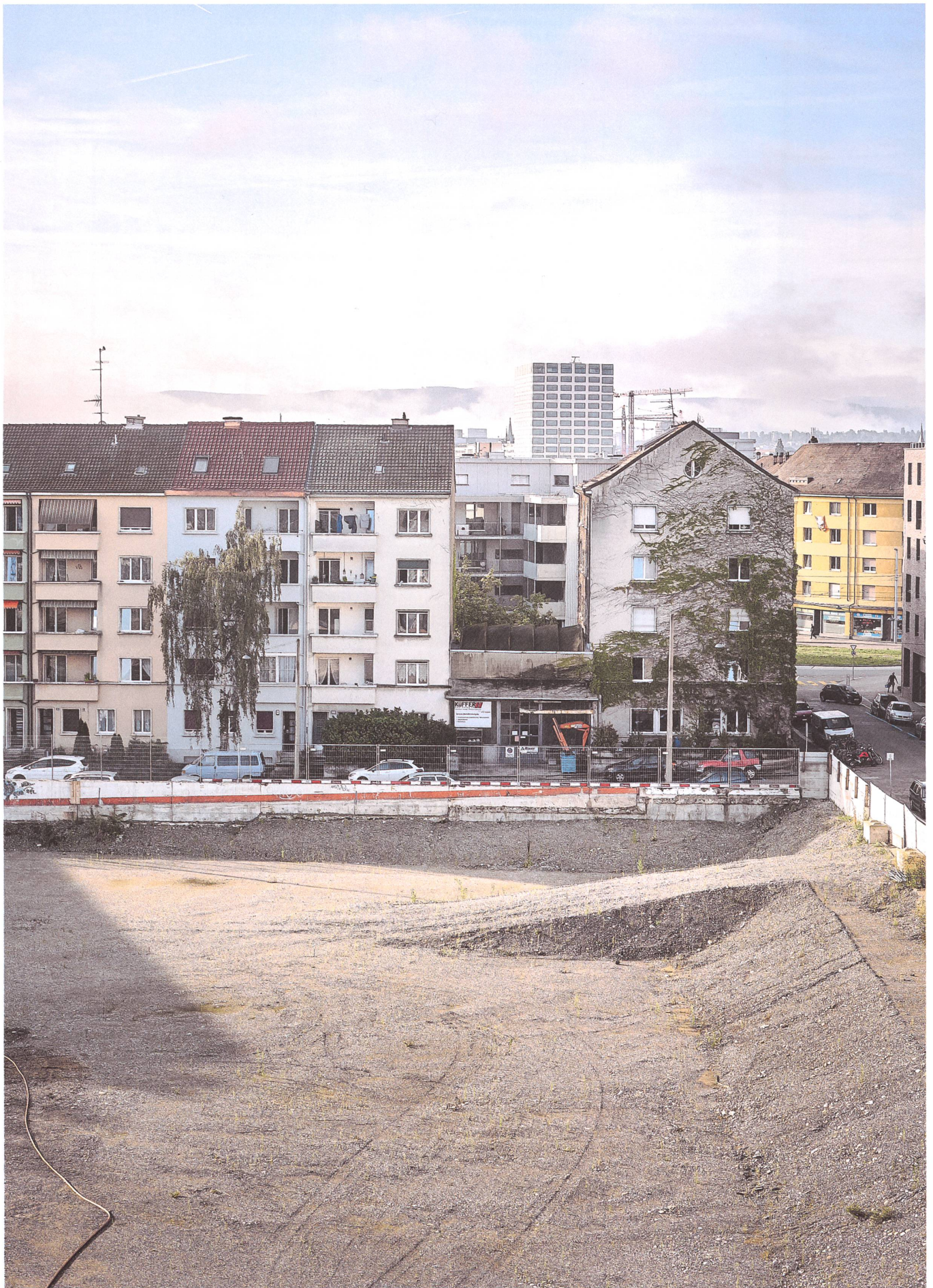
Das Quartier weiterbauen: Auf dem Lysbüchel-Areal vergibt die Stiftung Habitat zwölf Parzellen im Baurecht für Genossenschaftshäuser mit acht bis zehn Wohnungen.
