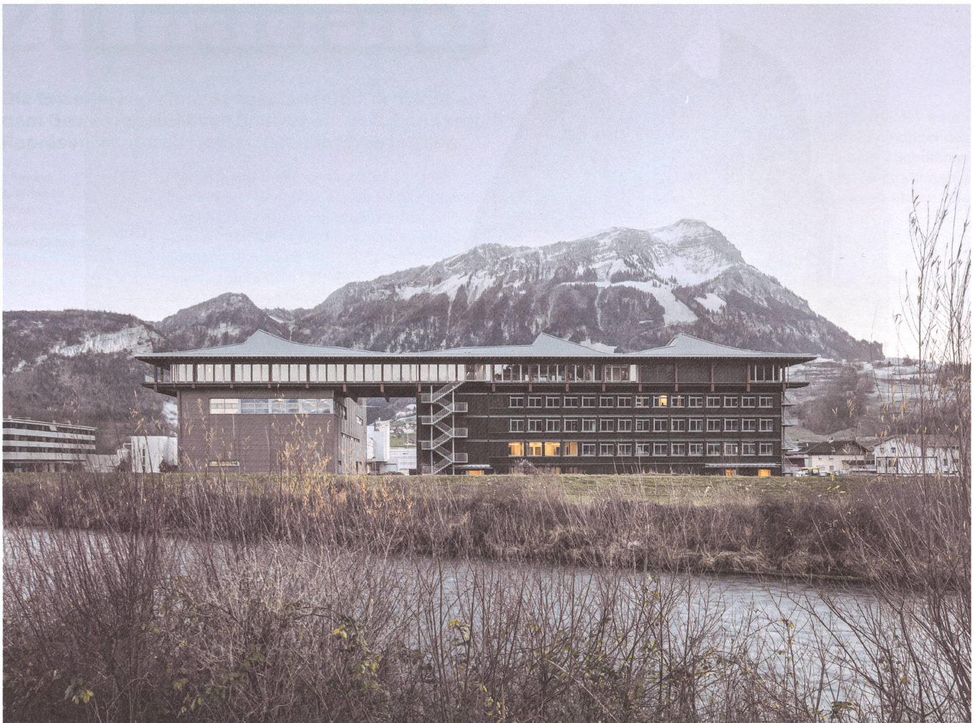
Eine Art Pavillon: Das repräsentative Dachgeschoss verbindet die bestehende Produktionshalle mit dem neuen Bürogebäude der Max Felchlin AG vor den Toren von Schwyz.
