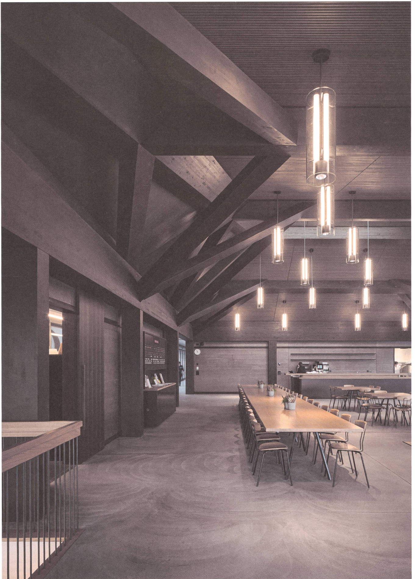
Raumgreifend, repräsentativ, raffiniert: die Holzkonstruktion des Dachtragwerks, hier über dem Mitarbeiterrestaurant.
