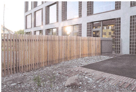
Klinkersteine bilden beim Kindergarten einen fließenden Übergang zwischen Kies und Asphalt.
