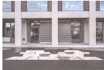
«Fussabtreter» aus Betonplatten, geschmückt mit gusseisernen Reliefs, markieren die Eingänge von Kindergarten, Primarschule und Bibliothek.
