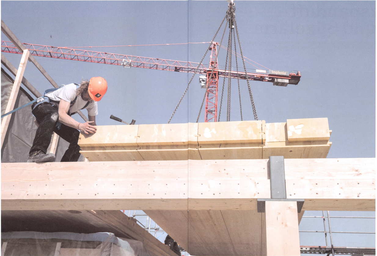
Geschoss um Geschoss: Nachdem die Stützen und Balken standen, setzten Holzbauer die Deckenelemente aus Brettschichtholz ein.
