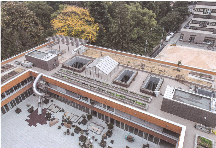
Der Innenhof mit Gemeinschaftsräumen und Clusterwohnungen liegt zwei Geschosse tiefer als der Pflanzgarten mit Treibkisten, Kompostanlage, Pergola, Gartenhaus und 500 Quadratmetern Fläche für Permakulturen.
