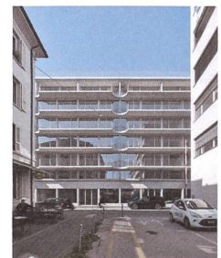
Umbau Geschäftshaus Neustadtstrasse, Luzern Rohrer Sigrist Architekten
