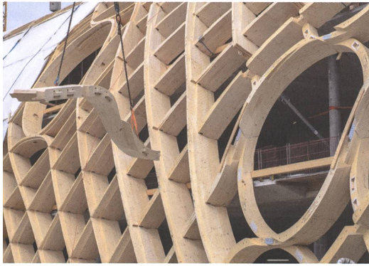
Die Holzelemente sind vielfach gekrümmt. | Les éléments en bois ont des courbures multiples. Photo: Swatch
