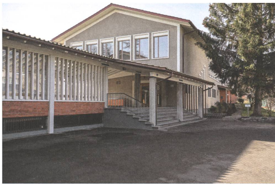
Schulhaus Brunnenmoos, Kilchberg: ein sorgfältig sanierter Zeuge der 1950er-Jahre.
