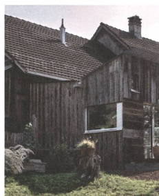
Ausbau Tenne, Mauren (FL) Schneider Türtscher
