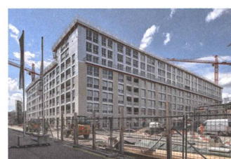
Wohnhaus Krokodil, Winterthur ZH Baumberger & Stegmeier und Kilga Popp
