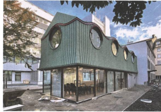
Hofgebäude St. Peter und Paul, Zürich Knorr & Pürckhauer
