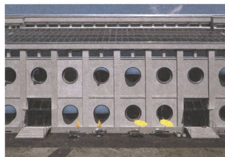
Umbau Silo Erlenmatt, Basel Harry Gugger Studio
