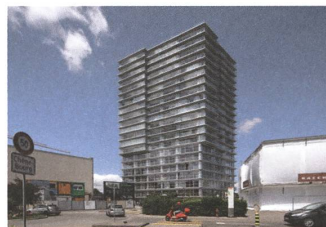
Wohnhochhaus, Genf Lacaton & Vassal
