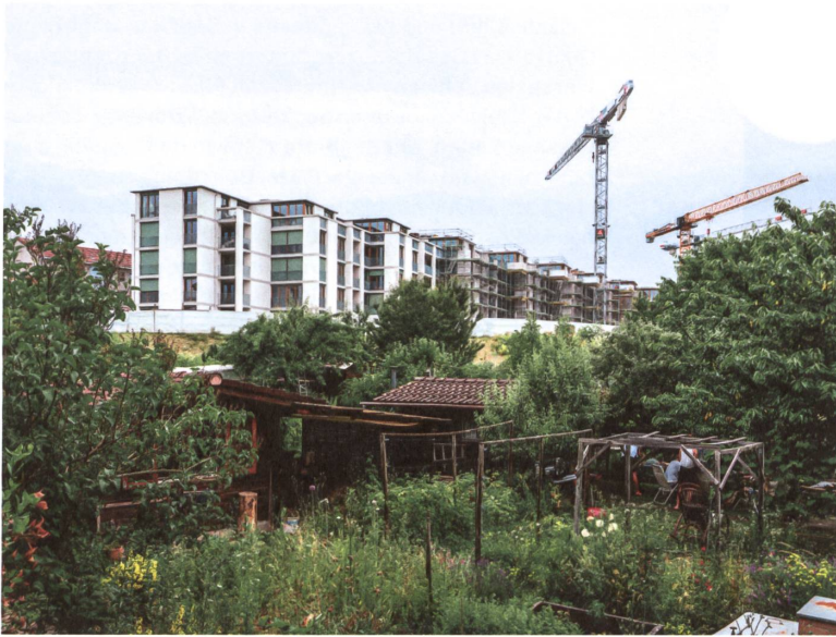
An der Basler Burgfelderstrasse reihen sich 126 Wohnungen in einem gestaffelten Riegel aneinander.
