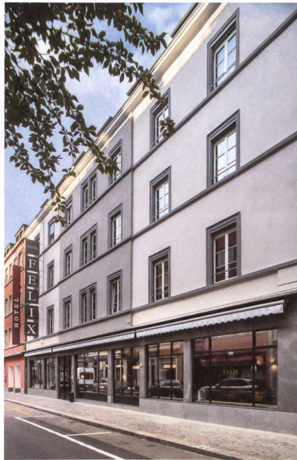
Die Fassade entspricht nun wieder dem Urzustand.
