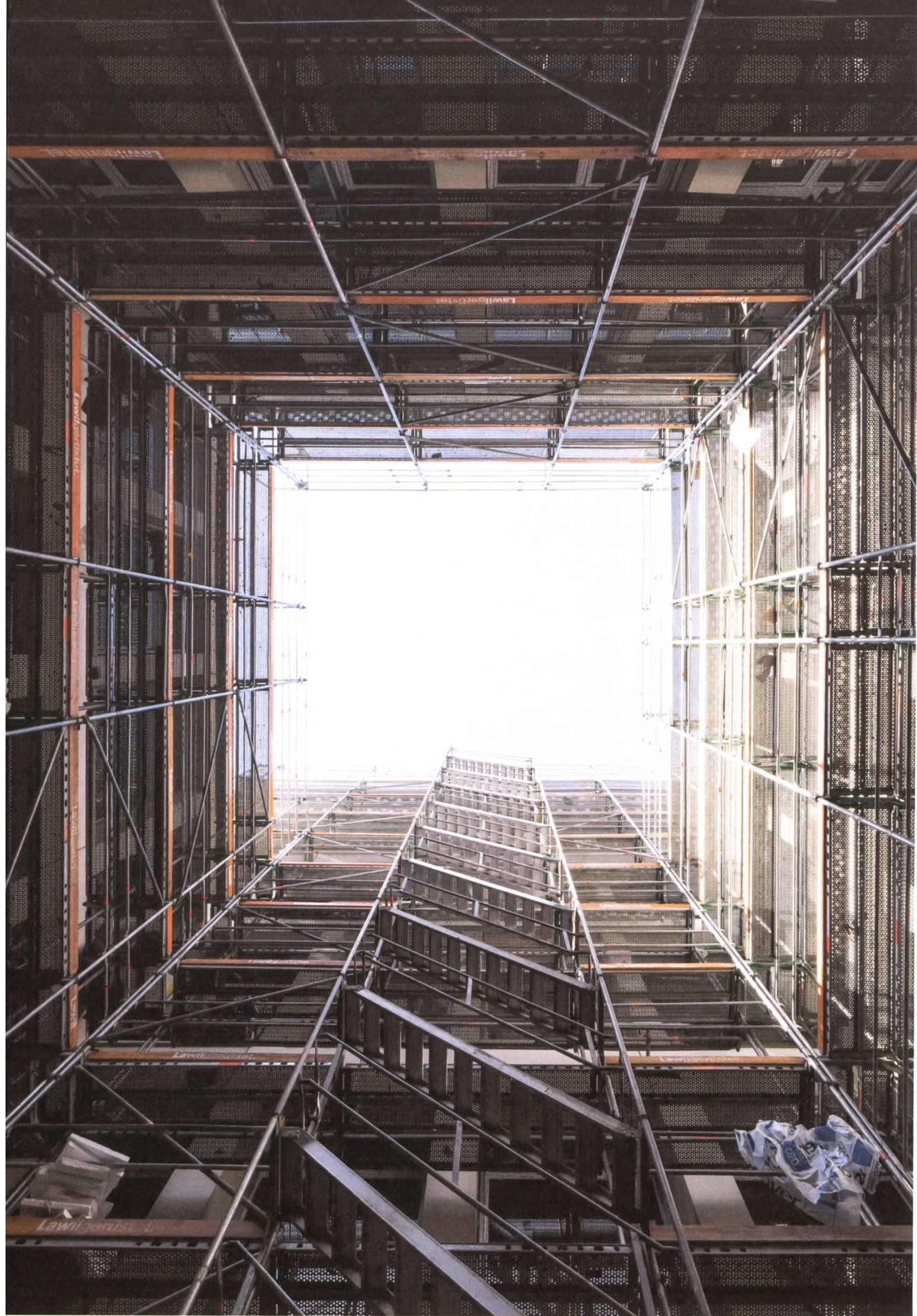
Altdorf: Neubau für das Kantonsspital Uri.
