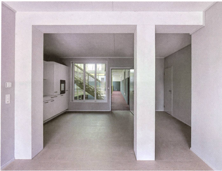
24 Die mächtigen Stützen und Balken aus Holz geben den Wohnungen der Überbauung Krokodil in Winterthur Halt.
