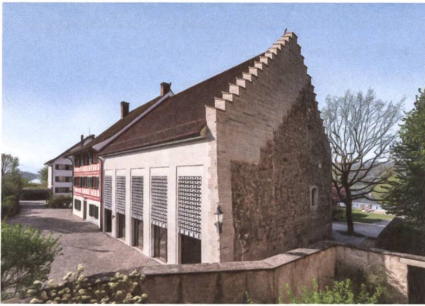
Die mittelalterliche Bruchsteinmauer des Landenberghauses in Greifensee haben die Architekten mit Sandsteinquadern ergänzt.
