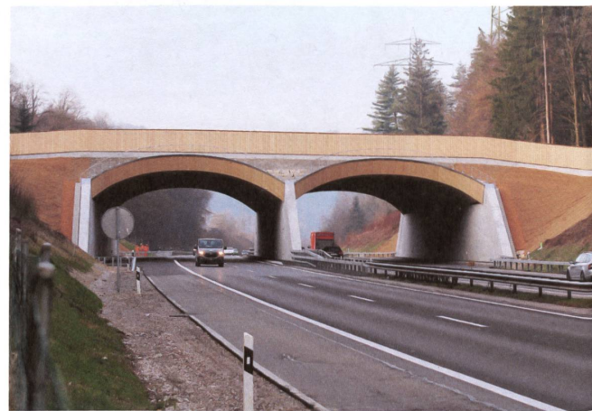
25 Mit der Wildtierüberführung bei Suhr stösst der Holzbau in neue Sphären vor. Foto: Astra
