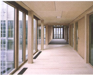
Die Holzstützen sind leicht konisch geformt.
