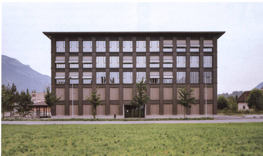
Die Fassade des OKB-Hauptsitzes in Sarnen ist klassisch gegliedert.
