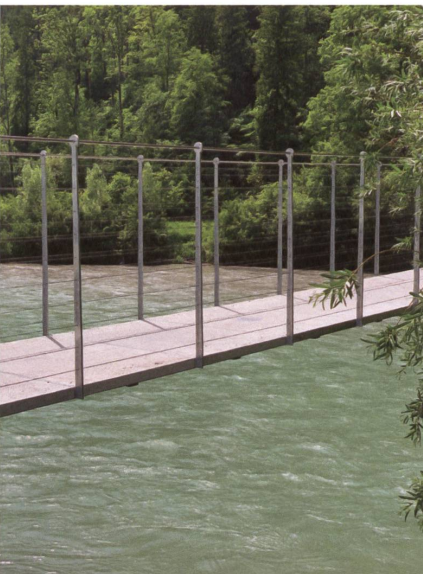
Die tragenden Betonplatten der Spannbandbrücke sind nur sechs Zentimeter dünn.
