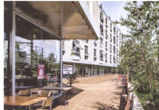
Zollhaus, Zürich Enzmann Fischer, Zürich
