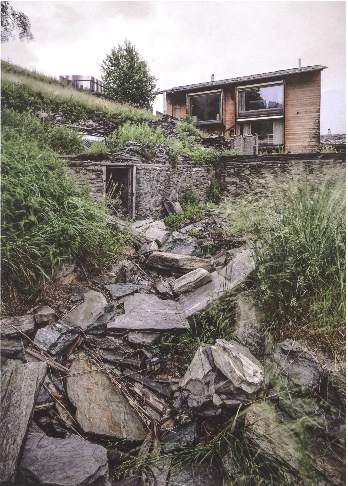
Relikt eines Männerbündnisses: das von Pius Truffer abgerissene Bauernhaus vor dem Strickbau von Peter Zumthor im Weiler Leis.
