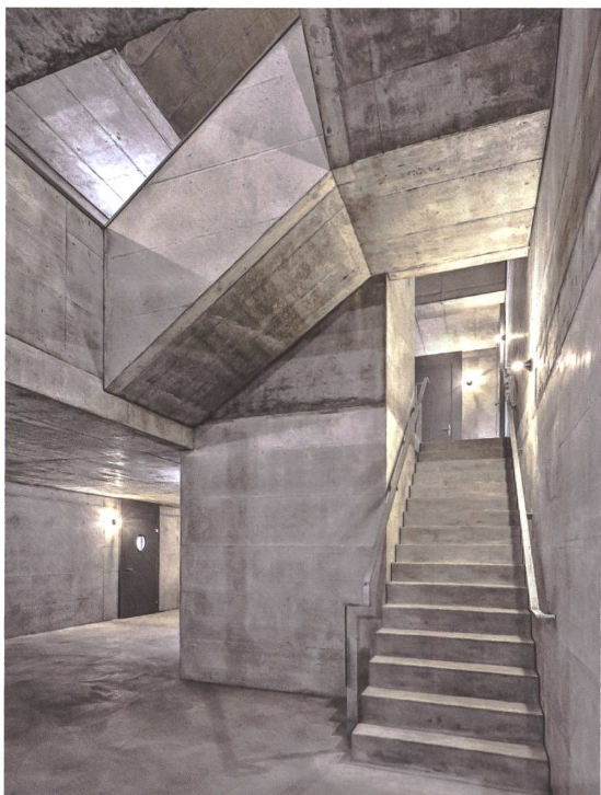
Das Treppenhaus ist ein barocker Betonraum.
