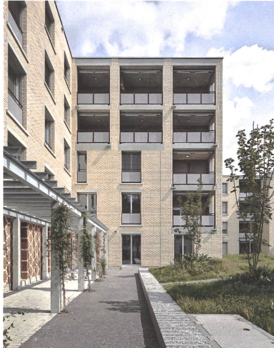
Bei der Wohnsiedlung Am Rain in Brugg schafft der gestaffelte Baukörper vielfältige Aussenräume.
