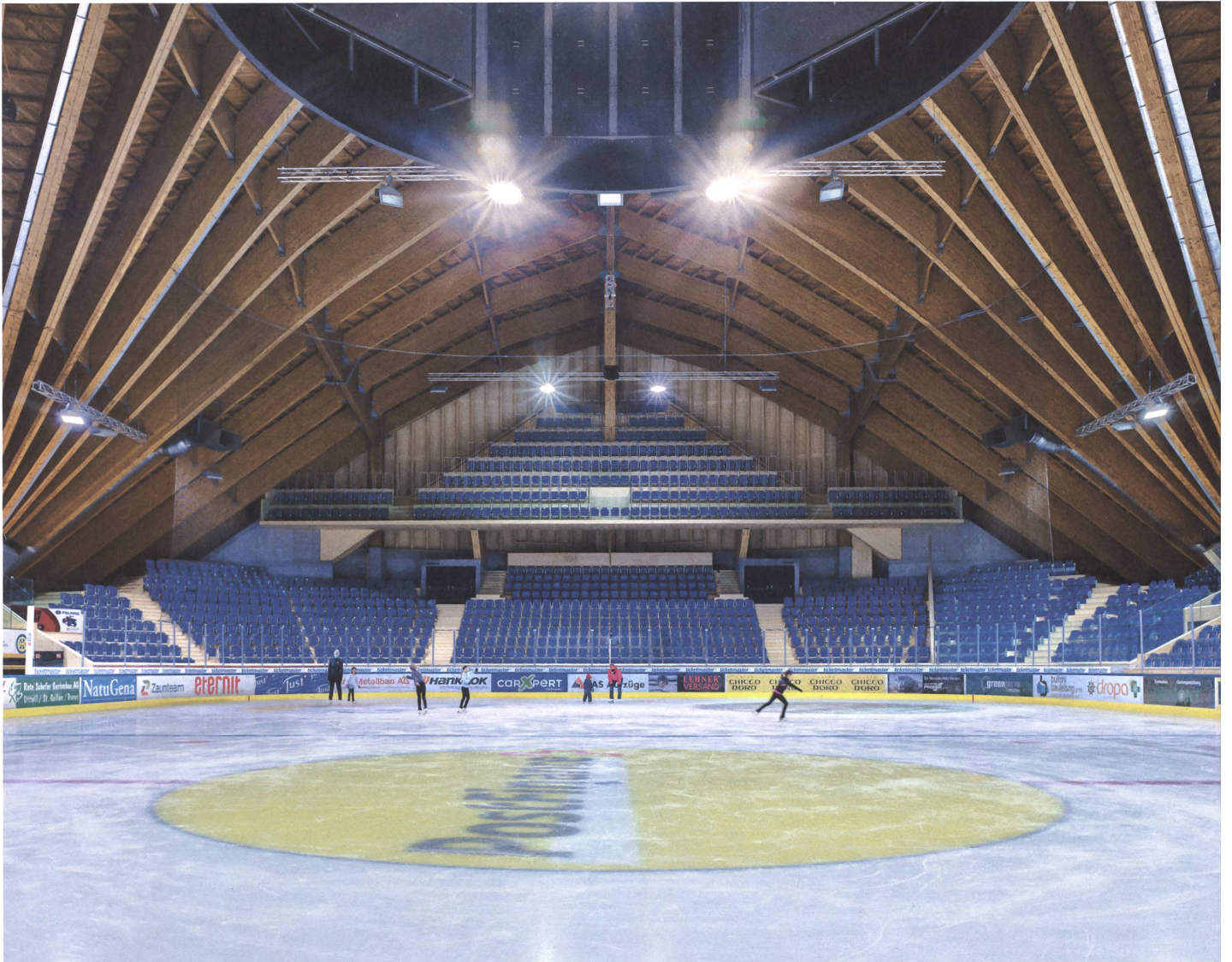
Das Herz des Stadions ist ausgebaut, aber erhalten: das grossartige Hallendach über dem Spielfeld, umringt von den Sitztribünen.
