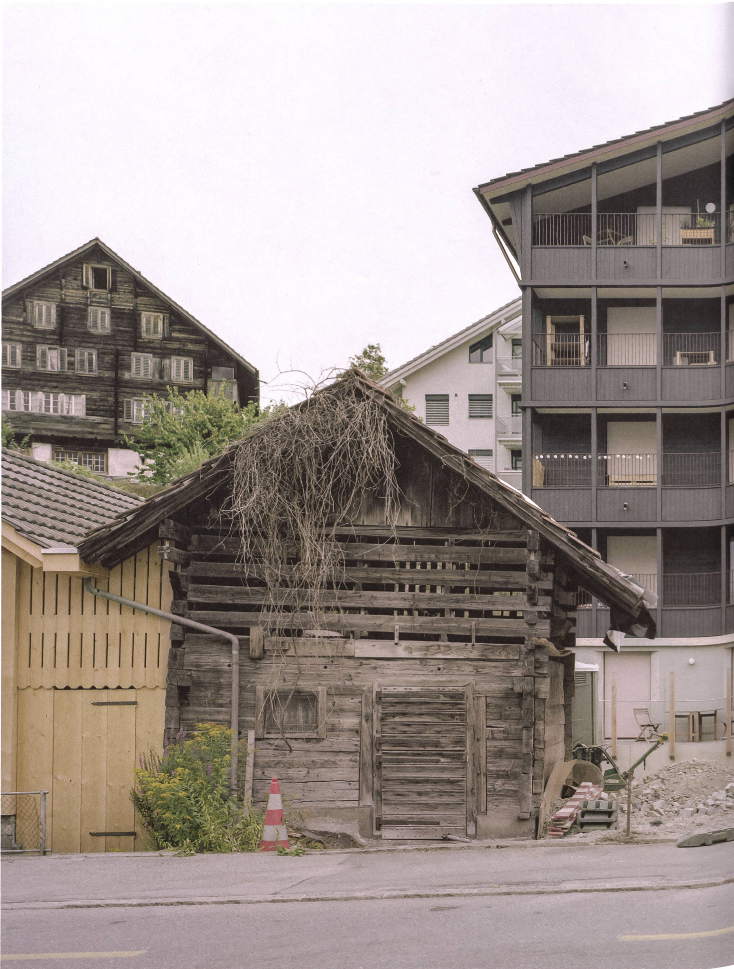
Nach der sanften Renovation des kleinen Schuppens neben dem Altbau ist etwa die Einrichtung eines Veloraums oder einer kleinen Werkstatt möglich.
