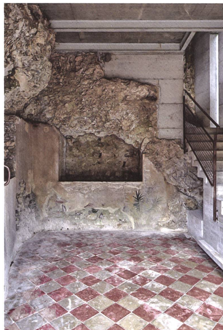
Roher Fels, Überreste von Malereien auf den alten Mauern und eine neu eingebaute Betontreppe prägen den Eingangsbereich.
