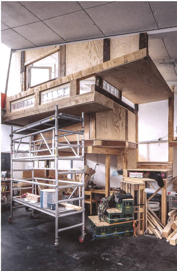
Formen des Selbstbaus: ein Fixspace im Aufbau. Oben entsteht ein Rückzugsort, unten ein Atelierplatz.
