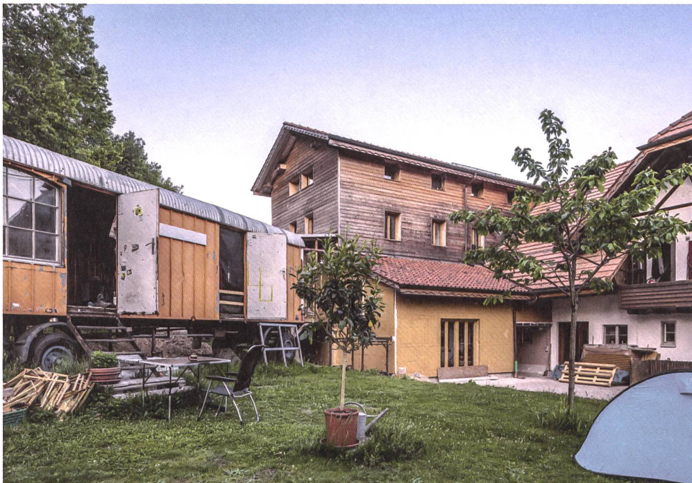
Auf der Rückseite des Hauses wird zurzeit eine weitere Wohnung angebaut.
