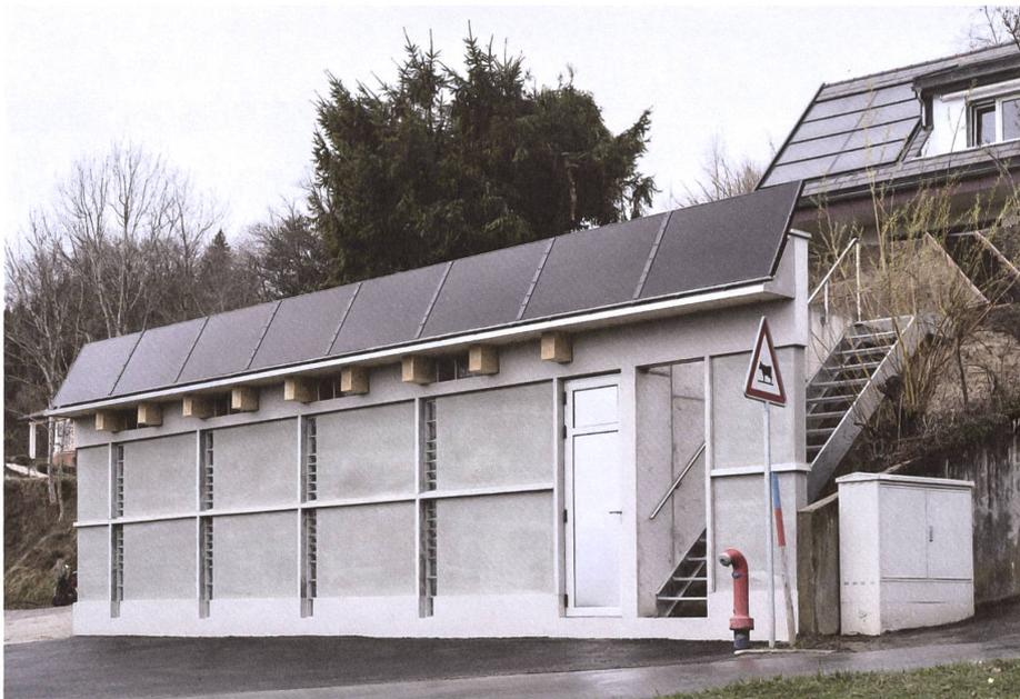
Die Fassade der Garagenerweiterung besteht aus in Beton gefassten Quadern aus lokalem Molasse-Stein und trägt ein Gesims aus Standard-Solarmodulen.
