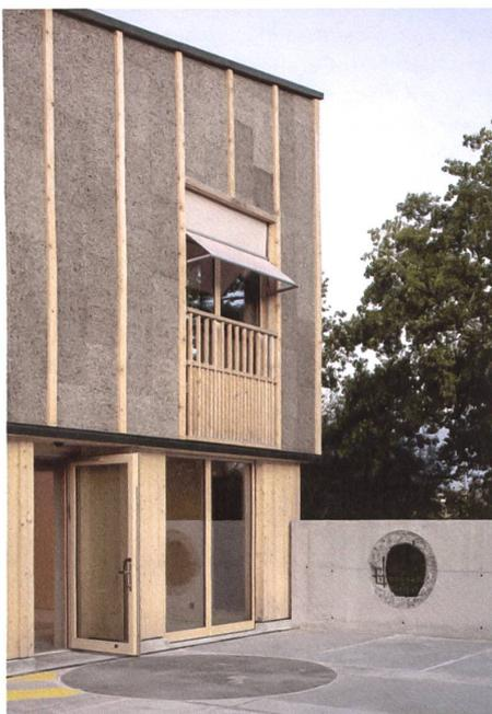
Fassade mit Fichtenholz und Korkdämmplatten.
