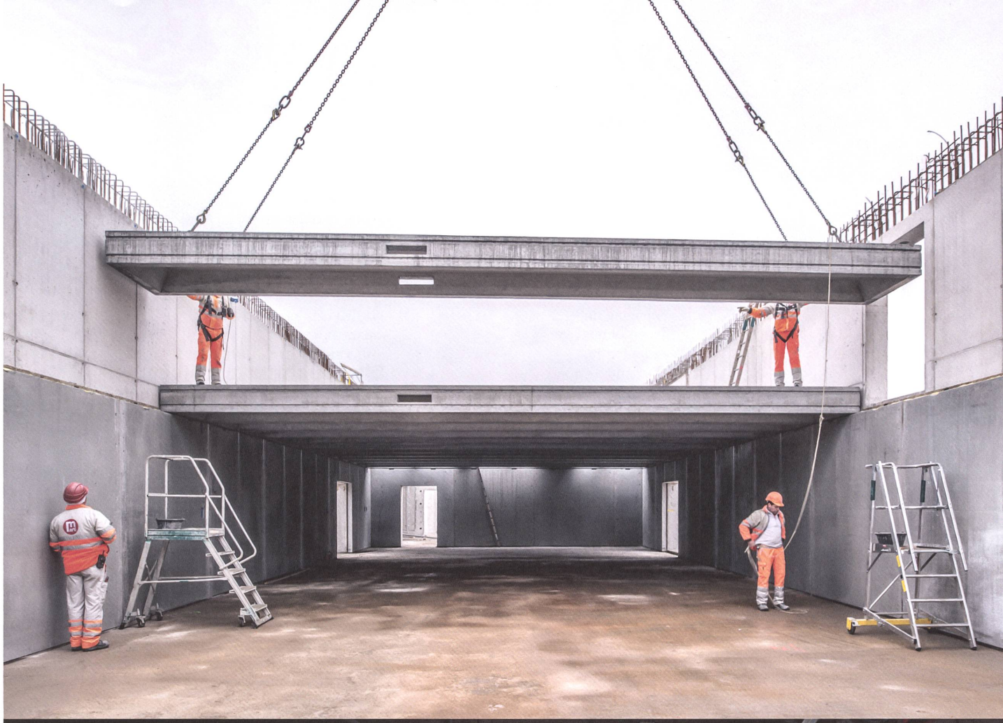
Versetzen von Deckenelementen Anfang 2018.
