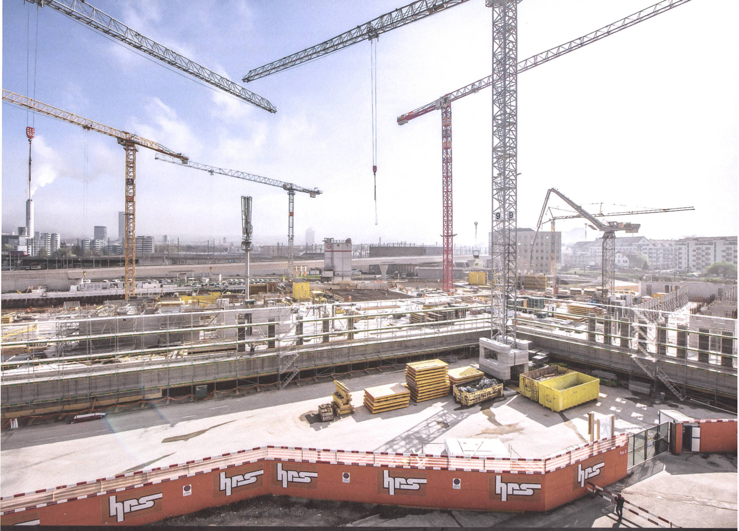
Im Frühjahr 2018 ist das Kranballett in vollem Gange.
