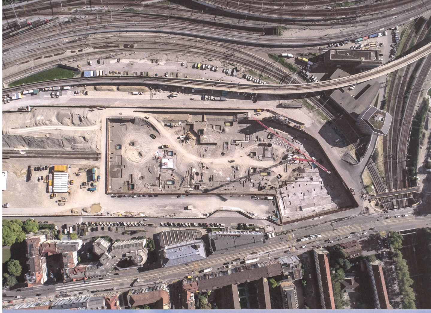
Im Sommer 2017 spielen sich die Bauarbeiten noch tief im Untergrund ab.
