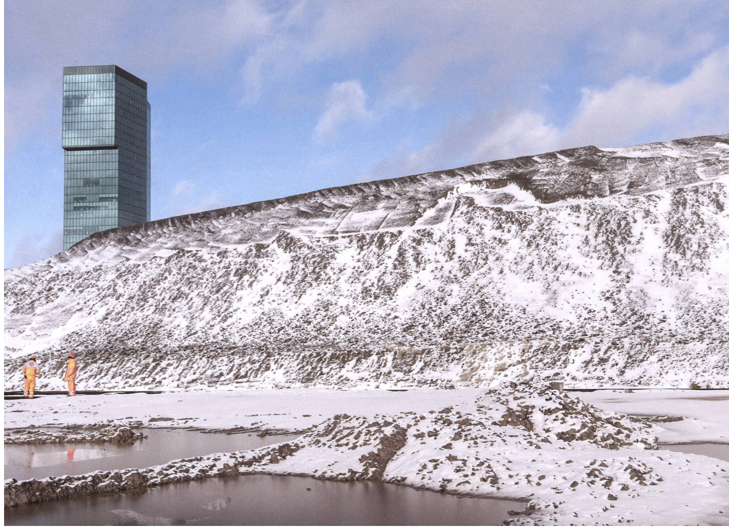
Im Januar 2018 ist am Rand der Baugrube vom PIZ noch nichts zu sehen. Im Hintergrund der Prime Tower.
