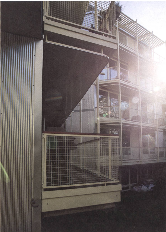
Eine luftige Balkonschicht öffnet das Haus auf der Rückseite hin zur Abendsonne.
