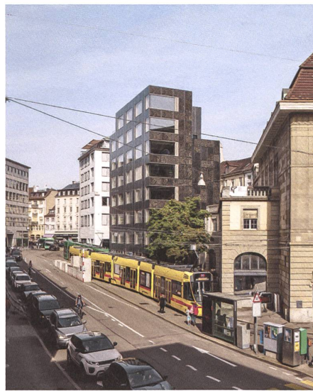
Das AUE-Gebäude steht mitten in der Basler Altstadt.
