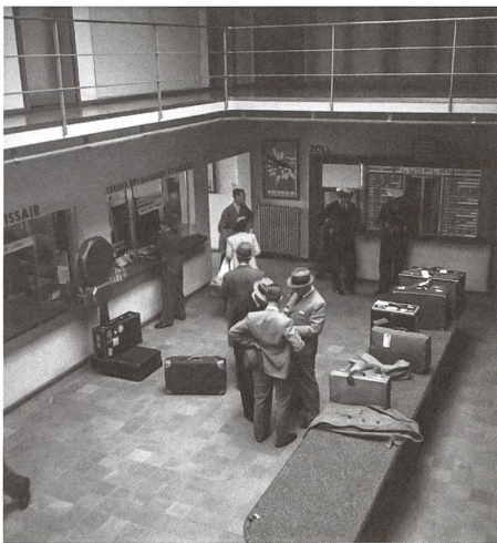
Passagierhalle im Abfertigungsgebäude.
