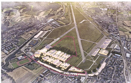
Etappe 3: Die Allee am Bebauungsrand nimmt Form an.
