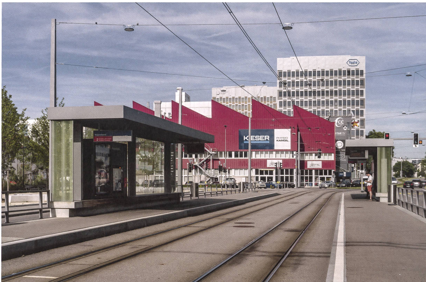
Schlieren: Auf dem Areal der einstigen Wagons- und Aufzügefabrik Schlieren sind neue Gewerbebauten entstanden. Früher wurden hier auch Trams gebaut. →
