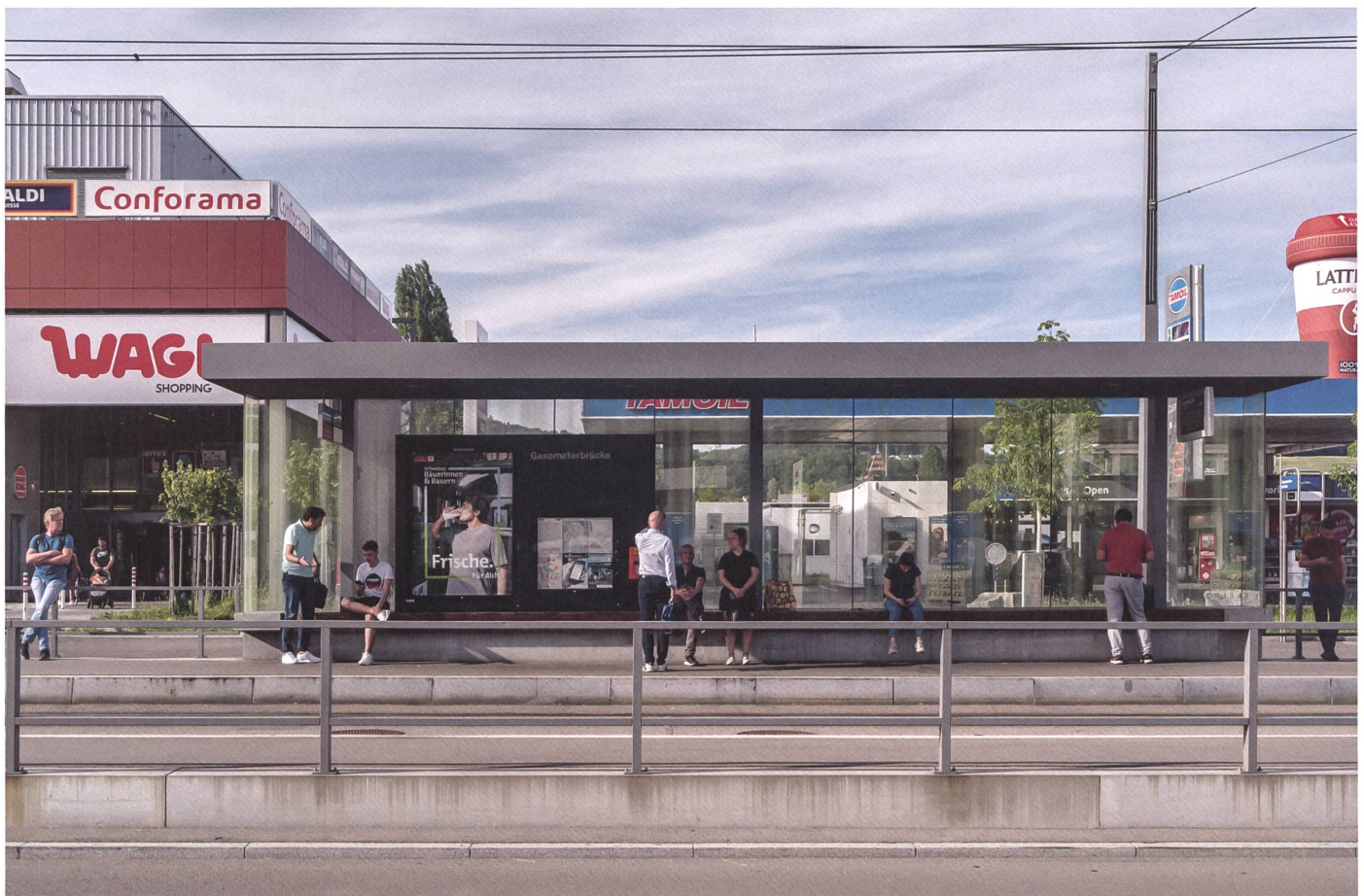
Schlieren: Bei der Haltestelle Gasometerbrücke dominieren die für Ausfallachsen typischen Nutzungen das Bild. Die Limmattalbahn setzt einen Gegenakzent. →
