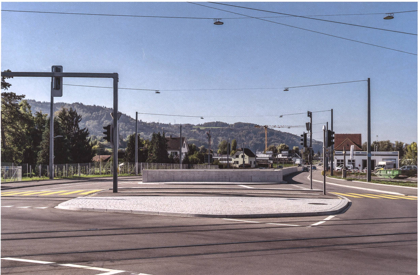
Dietikon: Der Bunkerknoten entflechtet die Strassen von Durchgangs- und Lokalverkehr und gewährt der Limmattalbahn freie Fahrt. →
