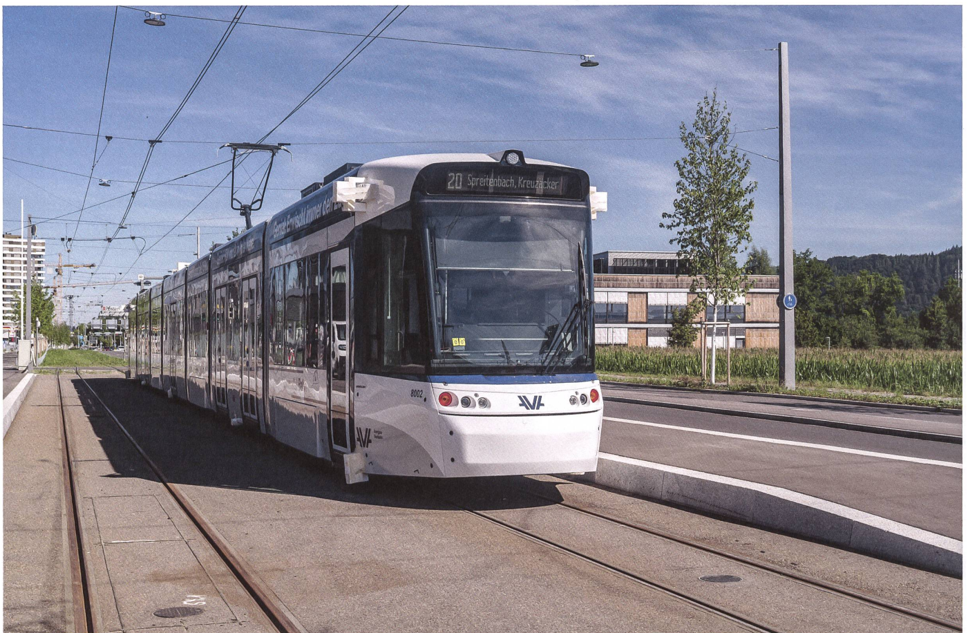
Spreitenbach: Die Limmattalbahn hält an der Station Kreuzacker, die die gleichnamige Überbauung erschliesst. →
