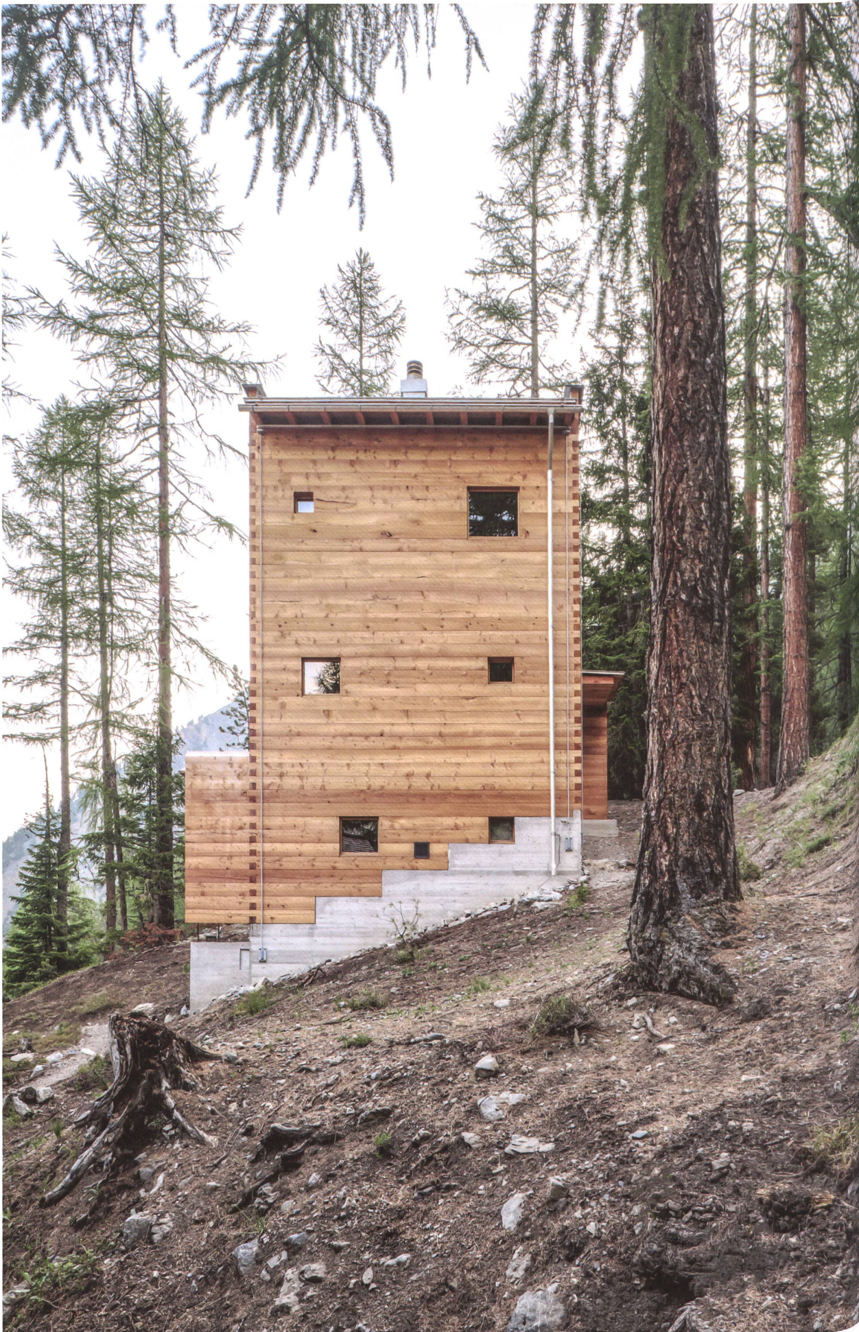
Der neue Turm dient dem Hüttenteam als Unterkunft – ein präzise geplanter und gefügter Strickbau aus Lärchenholz.
