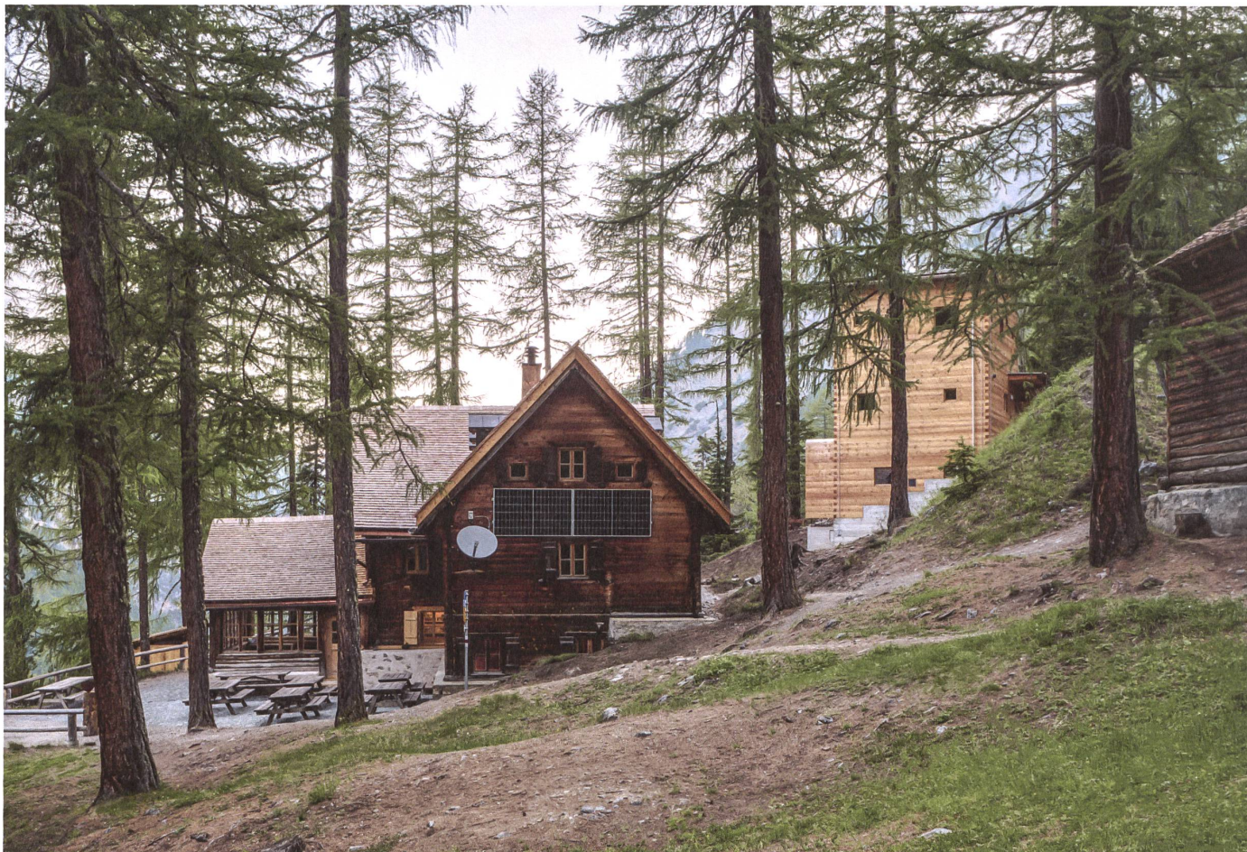
Ensemble im Lärchenwald: am Hang neben der Haupthütte der neue Turm und der alte Maultierstall.
