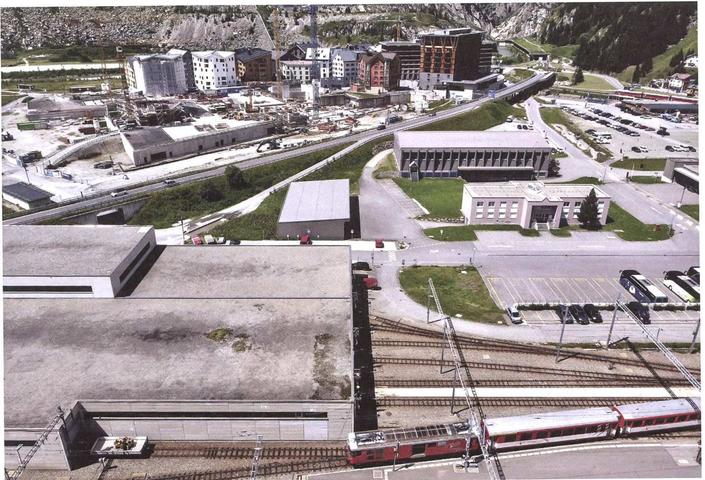
Baustelle auf dem ehemaligen Militärlübungsplatz: Das Feriendorf Andermatt Reuss wächst.
