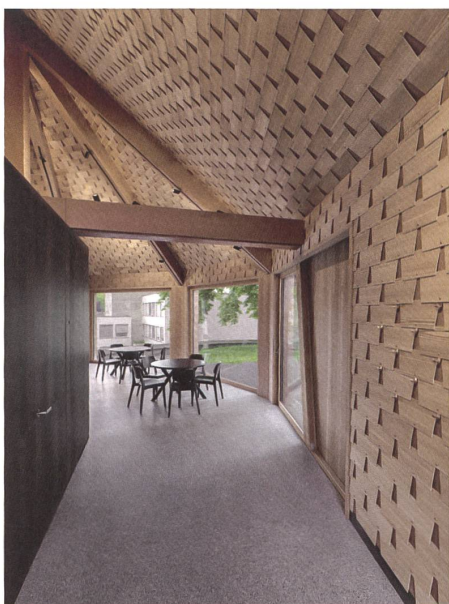
Ein Schirm aus Lärchenschindeln überspannt den neuen Treffpunkt.
