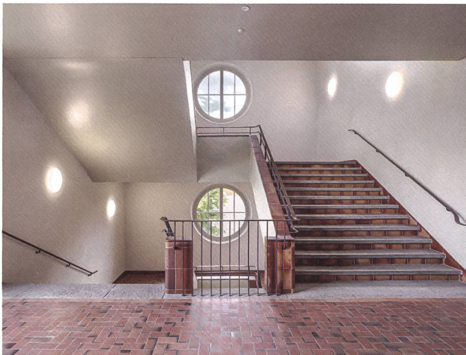
Treppenhaus mit dem charakteristischen Klinkerbelag.
