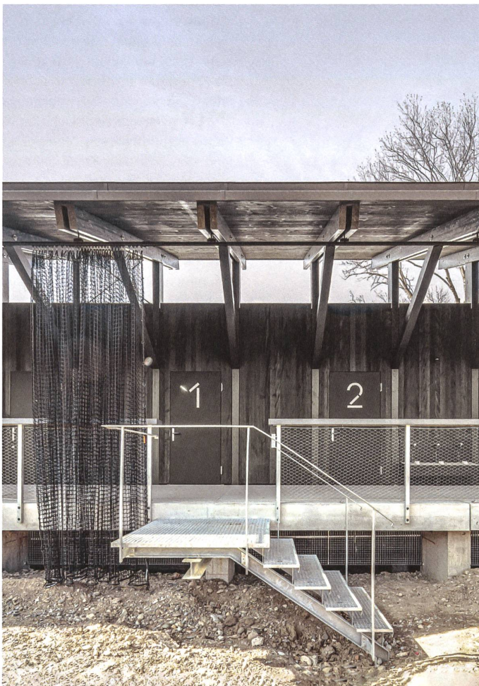
Das offene Dach schützt vor dem Wetter, in den hängenden Netzen landen die Bälle.
