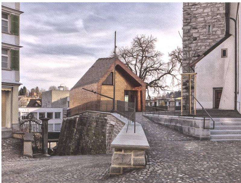
Das neue Nebengebäude der Kirche Herisau trägt ein Kleid aus Kupferschindeln und Baubronze.
