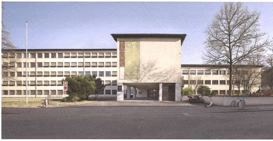
Das Wirtschaftsgymnasium Basel nach seiner Sanierung. Das Sgraffito «Das Meer» stammt von Max Kämpf.
