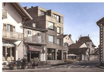
Wohngebäude, Vésenaz GE Atelier Bonnet, Genf
