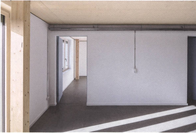
Hölzerne Stützen und Decken prägen die Räume in der Aufstockung.
