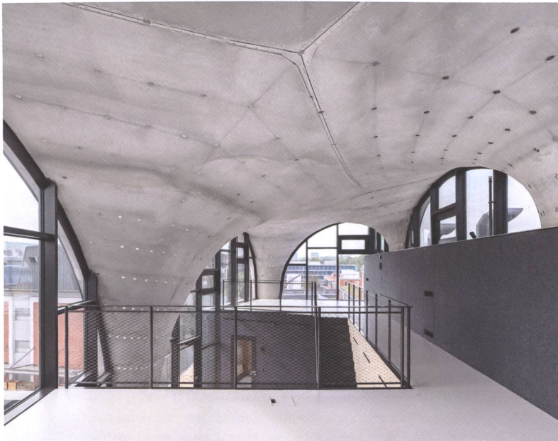
Die feinen Rillen der Deckenschale markieren die unterschiedlichen Betonieretappen.
