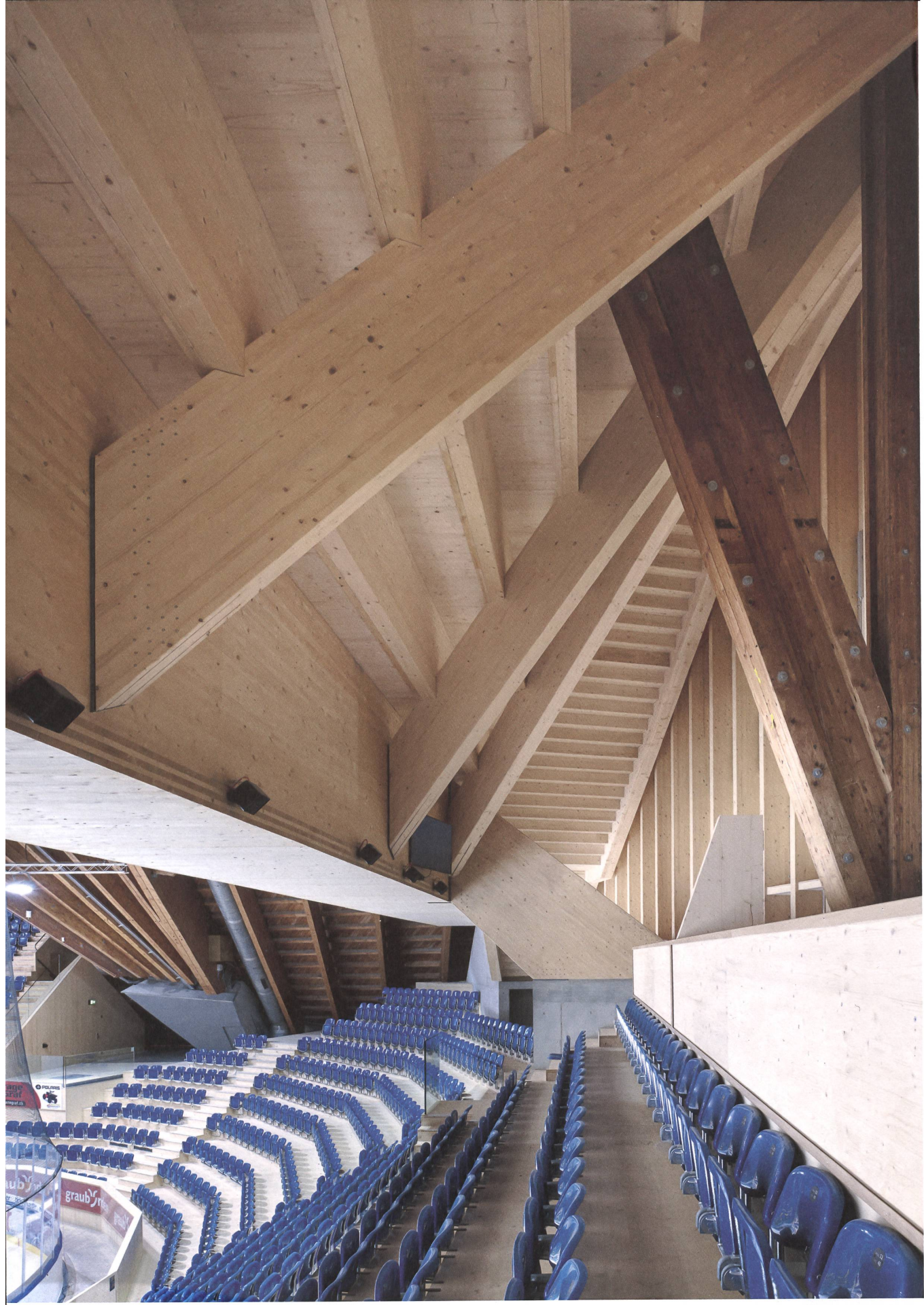
Im Innern des Eisstadions greifen alte und neue Balken ineinander und formen das grosse Dach fürs Davoser Hockeyspektakel. Foto: Ruedi Walti
