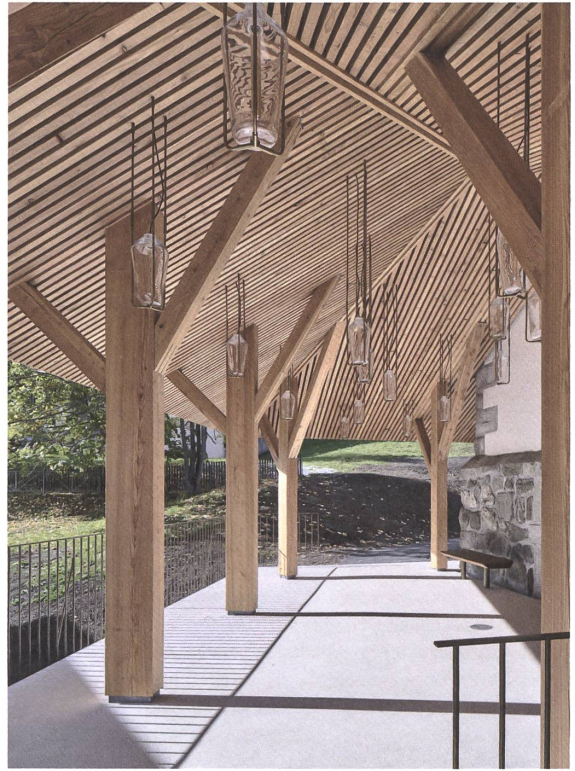
Holzstäbe, filigran zum Dach gefügt, schaffen Aufgang und Vorplatz.
