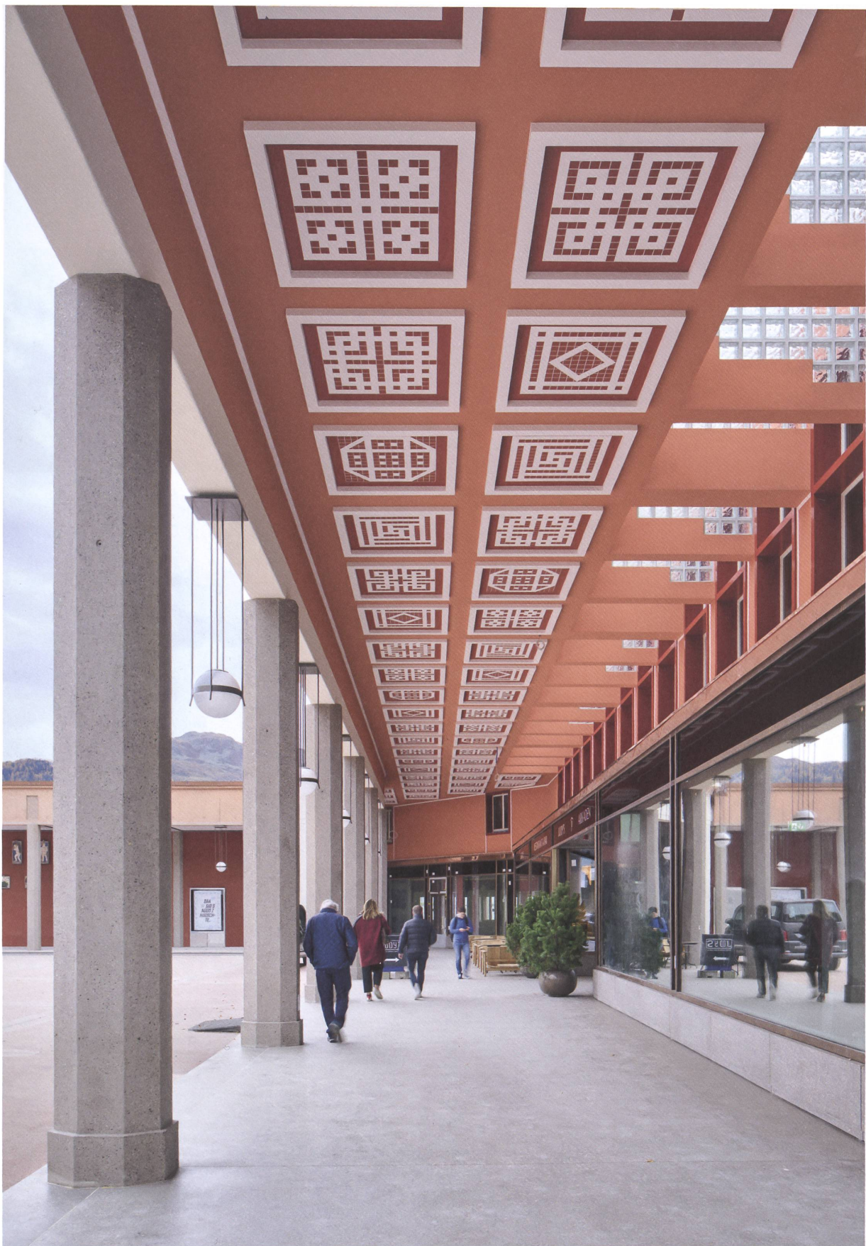
Mit grossem Können von den Architekten Jüngling und Hagmann rekonstruiert: der neue Flügel der Arkade für die Kantonalbank. Fotos S. 26/27: Ralph Feiner
