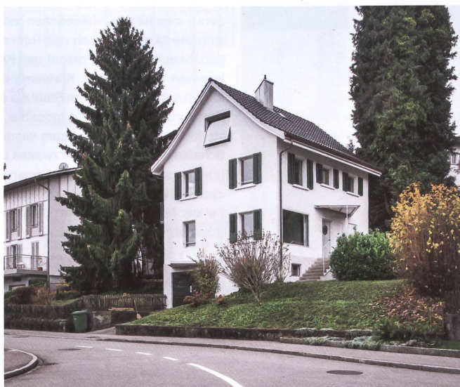
Erst auf den zweiten Blick erkennt man die Spuren des Umbaus in der Fassade.
