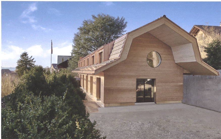
Der Ersatzneubau übernimmt die eigenwillige Dachform vom vorherigen Gebäude.
