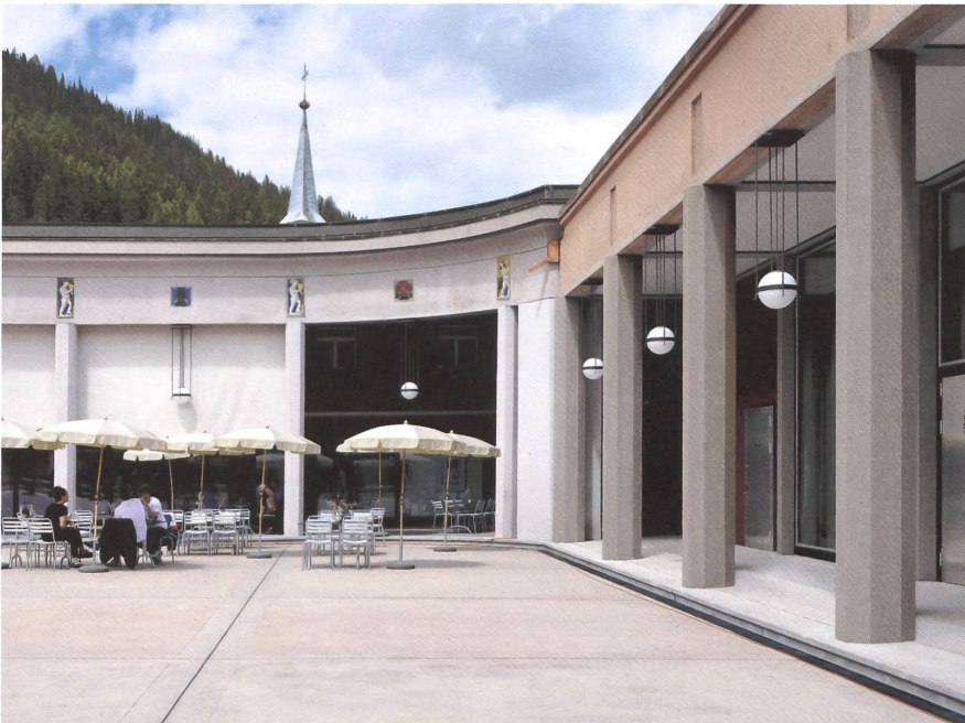
Arkadenflügel und Verbindungsbau. Man achte auf die Fugenkunst.
