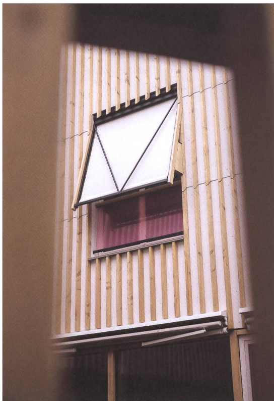
Der Sonnenschutz ist zwischen die schmalen Holzelemente eingepasst.
