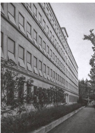
Quai Zurich Campus, 2021 Alfred-Escher-Strasse 45, Mythenquai 2, Zürich Bauherrschaft: Zurich Insurance Group Architektur: Adolf Krischanitz, Wien / Zürich Innenarchitektur: Iria Degen, Zürich; Stephan Hürlemann, Zürich Landschaftsarchitektur: Vogt, Zürich Totalunternehmer: Implenia Schweiz Sonnenschutz: Kästli, Belp
